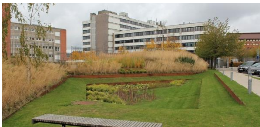
Figur 11. Olika varianter på nedsänkta torgytor som används för skyfallshantering.
