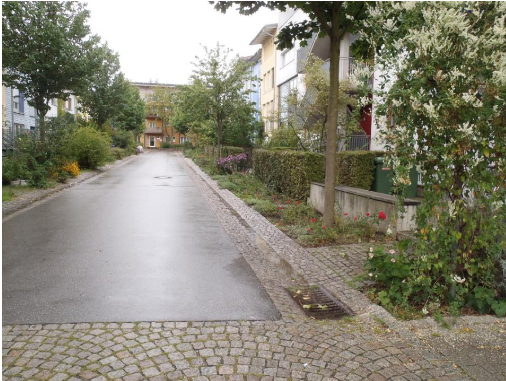
Figur 18. Skålformad ränna i gatsten i Freiburg (Ramböll, 2011)
